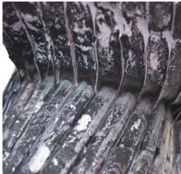
Tape skrelt av fra kabeloverflaten etter innpakning
